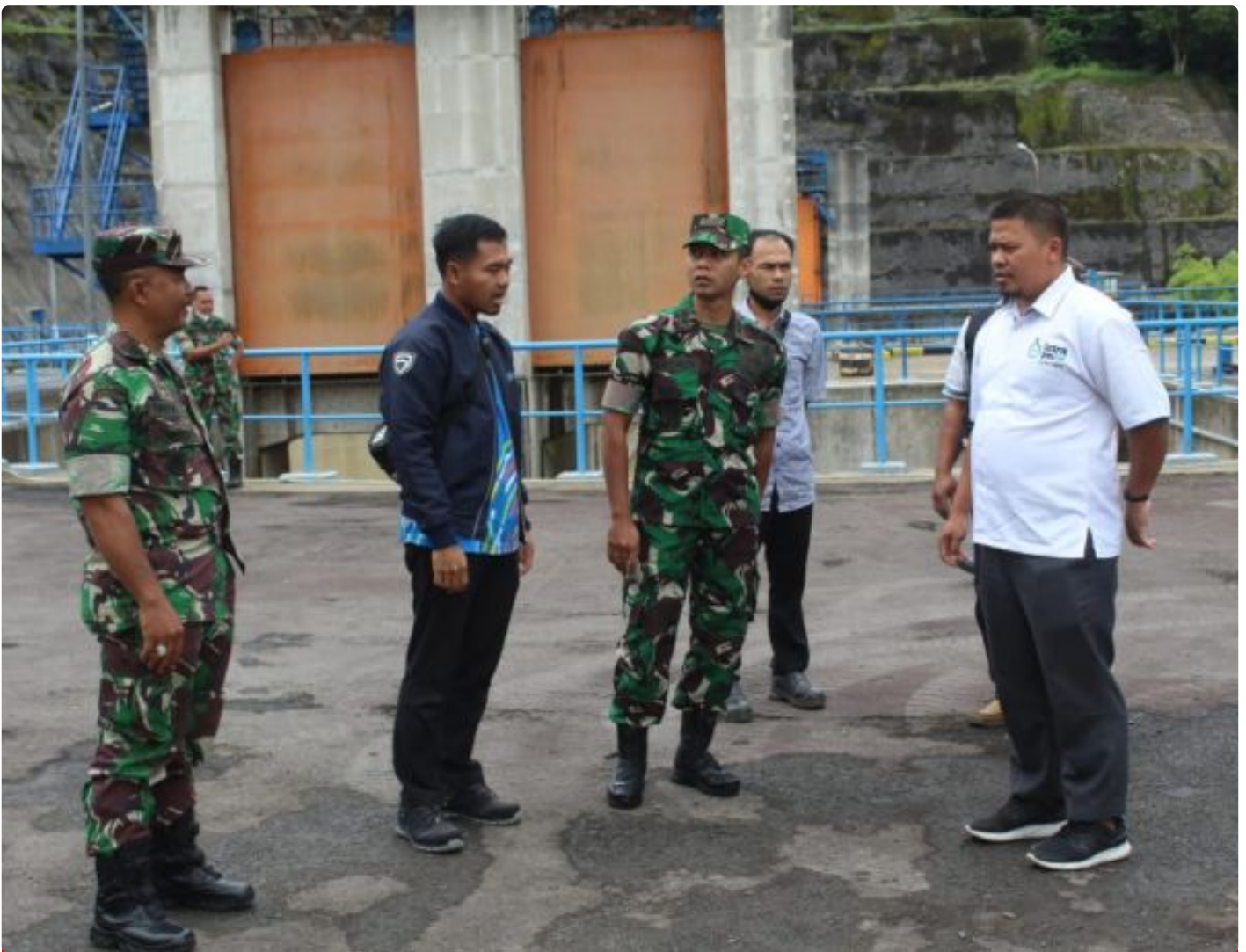
Komandan Kodim 0422/LB Meninjau Pembangkit Listrik Tenaga Air (PLTA) Dan Pembangkit Listrik Tenaga Mikro Di Wilayah Lampung Barat
