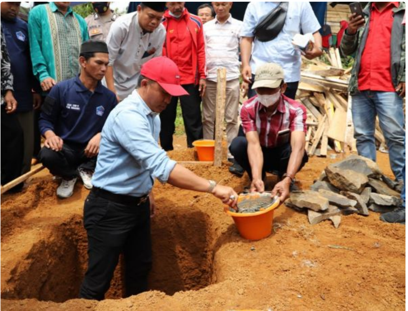
Peletakan batu pertama masjid at taqwa
